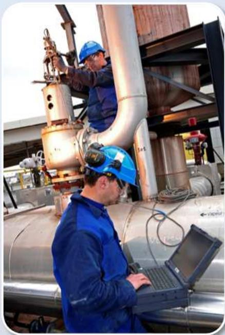
Les **Essais de Manœuvrabilité** permettent de s'assurer du bon fonctionnement des soupapes de sûreté dans leur environnement (y compris en zone **Ex ATEX**) avec une reprise éventuelle du tarage **sans déposer les soupapes**.
